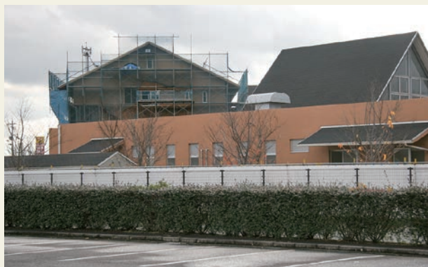
2006年 工事中の三宅キャンパス中学棟・食堂の屋根 時計塔はまだない
