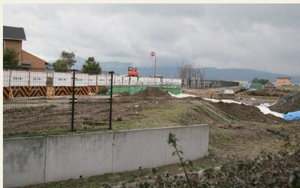
2006年 工事中の三宅キャンパス北門付近 背後は比良山
